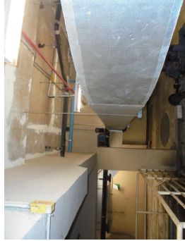
ภาพที่ 3-9 ท่อระบายอากาศที่ระบอบำบัดน้ำเสีย มีระบบอากาศดีดักและระบบอากาศออก
