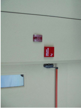
ภาพที่ 3-27 อุปกรณ์แจ้งเหตุเพลิงไหม้ด้วยมือ
