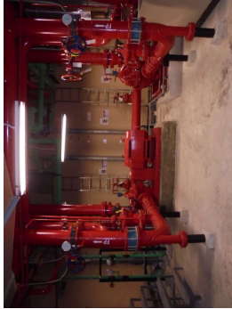
3-20 ห้องเครื่องสูบน้ำดับเพลิง
