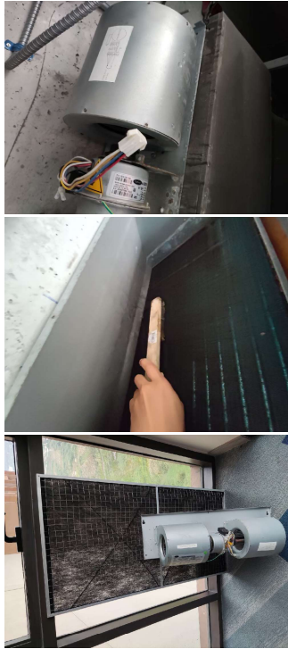
ภาพที่ 3-45 กำลังทำความสะอาดระบบปรับอากาศของอาคาร
