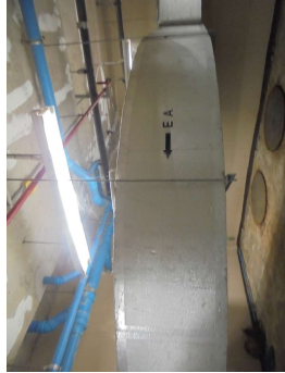
ภาพที่ 3-9 ท่อระบายอากาศที่ระบอบำบัดน้ำเสีย มีระบบอากาศดีดักและระบบอากาศออก
