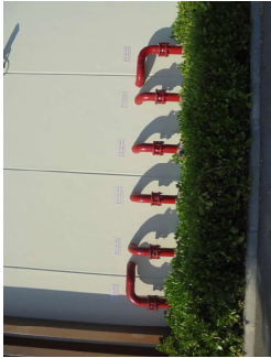
ภาพที่ 3-23 ท่อรับน้ำดับเพลิงจากภายนอกของโครงการ
